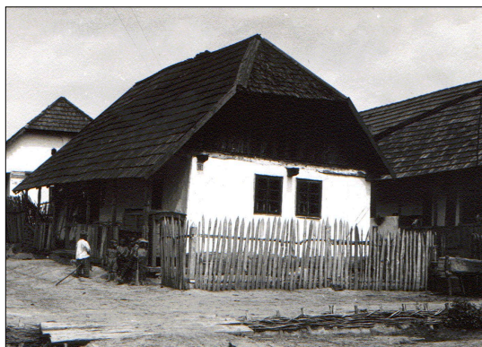
21. kép. A XX. század fordulója körüli, eredetileg zindelyezett ház. Jól látszik a kilógó mestergerenda és a fölötte fekvő koszorúgerenda oldalába fűrt lyukak sora. Ez utóbbi azt jelenti, hogy lebontott ticsos ház gerendáját használták fel újra (Dincsér Oszkár felvétele)
