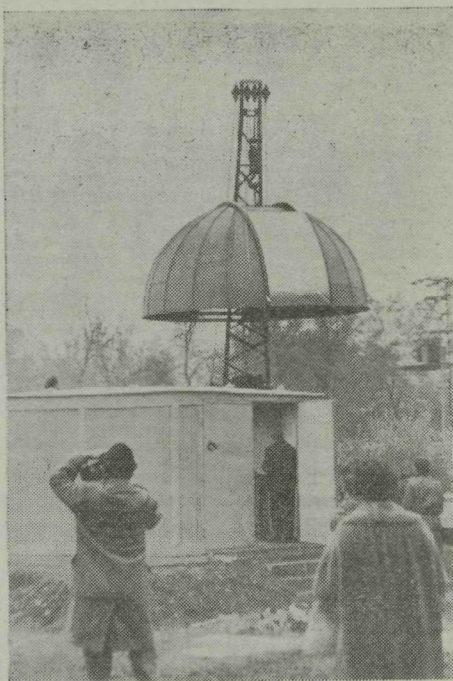
A csillagvizsgáló kupolája szerelés közben
