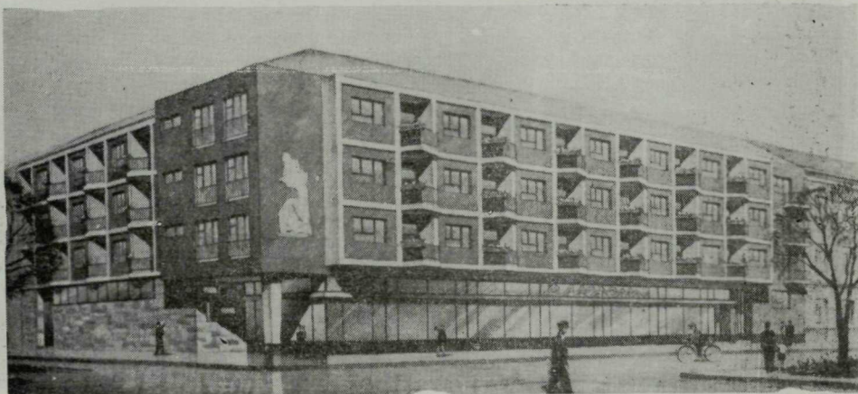
A főter — Solyom utca sarok az épület felépítése után.
