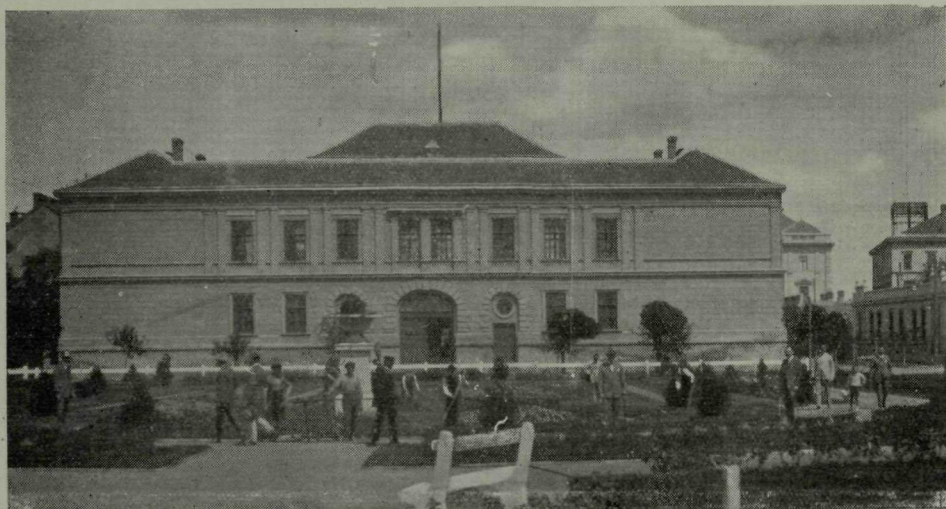
A Szolnok Megyei Tanács székházának eredeti hátsó homlokzata. (A felvétel 1926-ban készült.)
