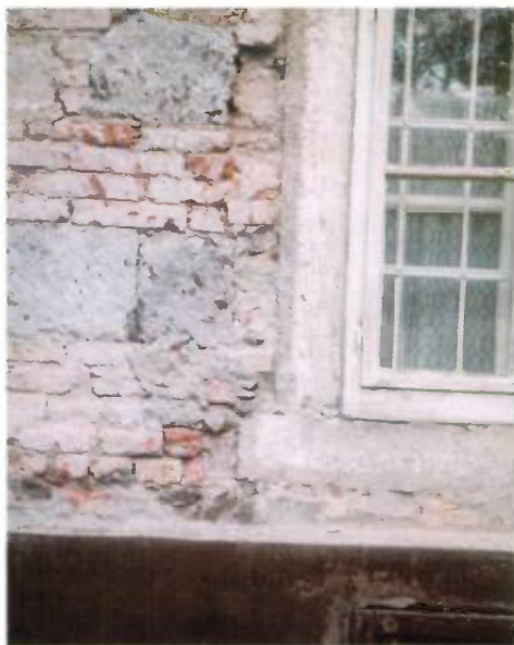
11. kép. Másodlagosan összeállított, levéselt tagozatú barokk ablakkeret a keleti külső homlokzaton
