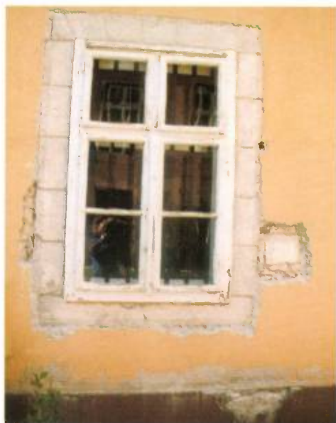
26. kép. Másodlagosan összeállított, levésett tagozatú, utólag sávozott felületű barokk ablakkeret az udvari földszinti árkádok elfalazásában
