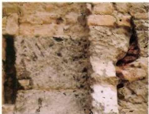
25. kép. A faltükör kialakításakor megvésett barokk oszlopfejezet a nyugati szárny udvari homlokzatán
