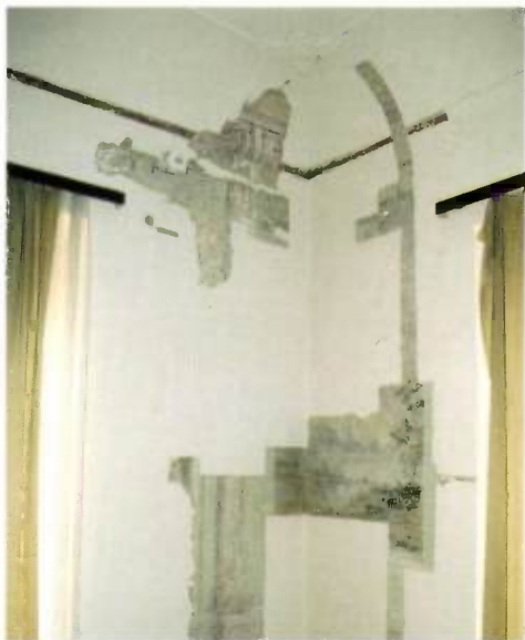
1. kép. Emelet 112-es helyiség. A nyílászárókat architektúrális festés keretezte. A festés a járószinttől a holkerig maradt meg. A barokk ablak eredetileg 40 cm-rel jobbra végződött. A másodlagos sarok stukkódíszje papírmaséból készült.
