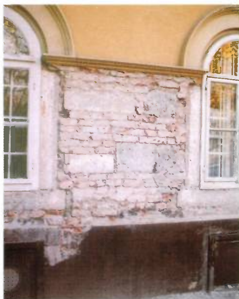
13. kép. Klasszicista falköpeny a keleti homlokzat barokk kori szakaszán
