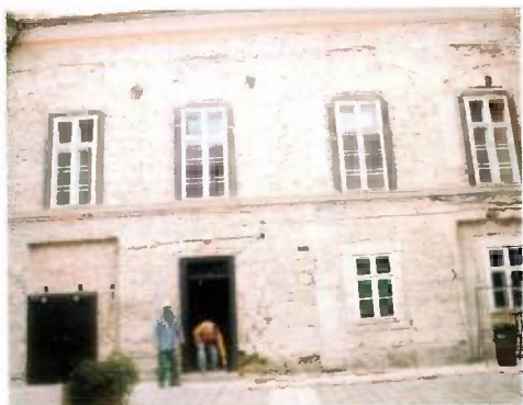
17. kép. A keleti szárny udvari homlokzata
