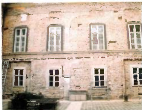
19. kép. A nyugati szárny udvari homlokzata
