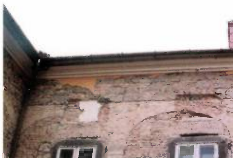
32. kép. Az elfalazott emeleti árkádok a nyugati szárny udvari homlokzatának emeletén
