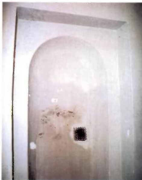
50. kép: Félköríves alaprajzú fülke az épület északi felében (25. számú helyiség)
