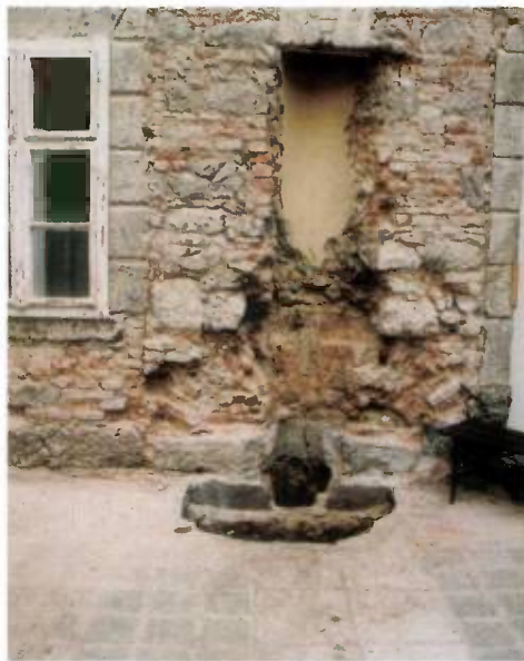
30. kép. Falikút és kút maradványa az északi szárny földszinti, udvari homlokzatán
