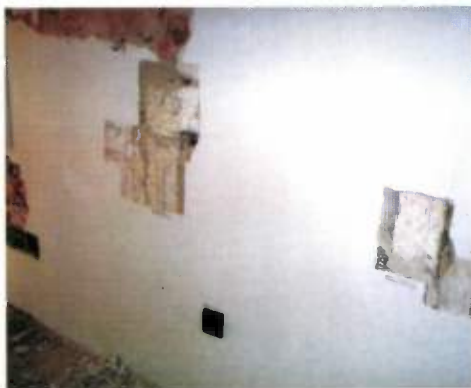
66. kép: Barokk fűtőnyílás a 114. számú helyiségben
