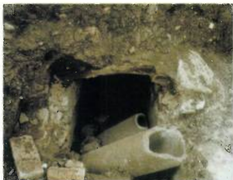
3. kép. Az ülepítőaknába vezető csatorna
