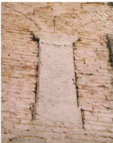
31. kép. Az emeleti árkád kőoszlopa a déli szárny udvari, emeleti homlokzatán
