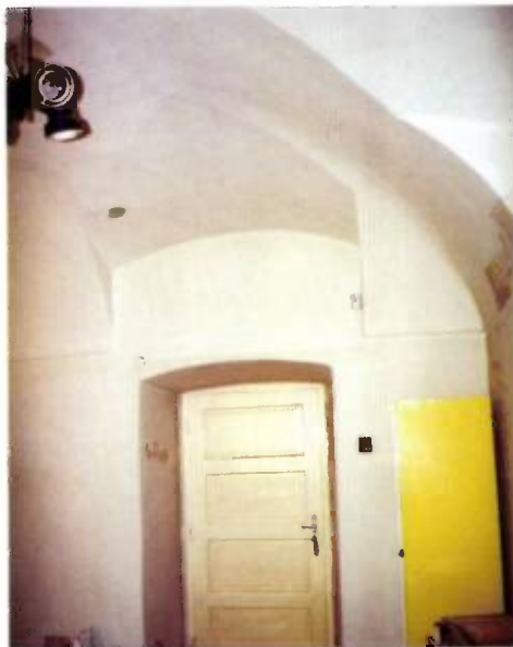
54. kép: Ajtónyílás a 43. számú helyiség északi falában
