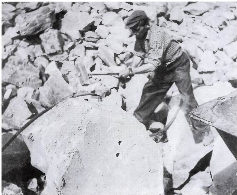
8. kép Kis hegyi bányában kőhasítás kézi úton, 1957-ben. Bakó Ferenc felvétele. DIV. Fotoadattár, 6466.
