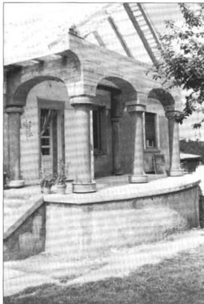
20. ábra. A Szikra utcai ház megújult, kosáríves terasza. Veszprém 1996. LDM Fotónegatívár N/10464. (Fotó: Oszkó Zs. 2001)
