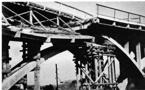
14. ábra. Veszprémi viadukt légitámadás után (1945. márc. 22.) Fotó: Streit József, Veszprém
