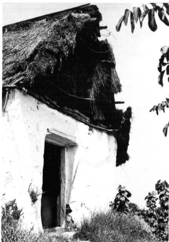
1. ábra. Vályogfalú, kétosztatú parasztpince homlokzata. Zsüpfedelű, a vásárhelyi oldal Pados-féle pincéje.
