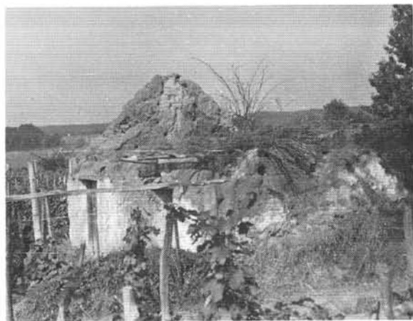
4. ábra. Vályogfalú, vályogoromfalú, kétosztatú rom-pince. Az oromfal vályogtéglaí középen és az oromfal két szélén, a fal síkjára merőlegesen rakottak. Jenei oldal.
