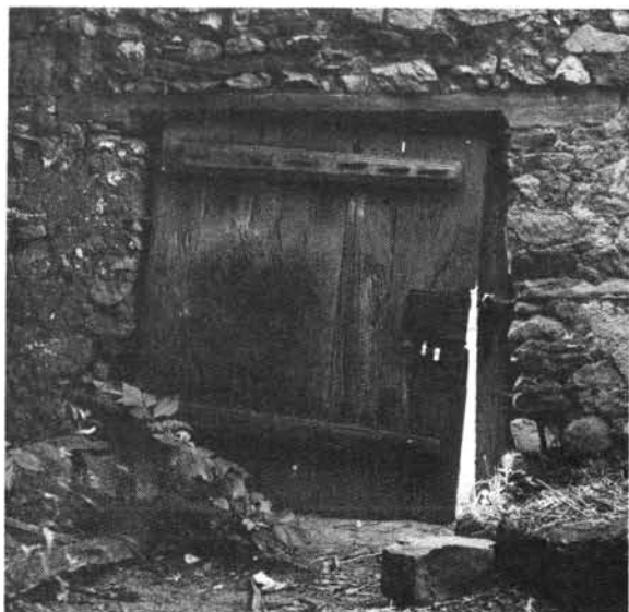
11. ábra. Pinceajtó belülről.
