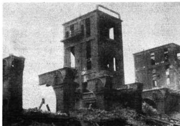
20. ábra. A lebombázott péti ipartelepek romjai. (1944. július) Fig. 20: Ruins of the bombed Industrial Works Pét (July 1944)
