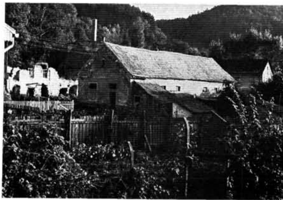
E) A „C” épület és a romos gyárépület nyugatról. E) Westansicht der „C” Anlage und des kriegsbeschädigten Fabrikbaus. E) Le bâtiment «C» et le bâtiment de l’usine en ruines, vue du côté ouest. E) Здание «C» и развалины заводского здания с запада.
