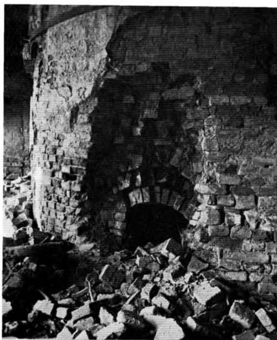
F) Az „A”/IV. sz. épület körkemencéjének tüzelőnyílása. F) Feueröffnung des Rundofens im „A”/IV. Bau. F) Porte du foyer du four circulaire du bâtiment «A»/IV. F) Топка кольцевой печи в здании «A»/IV.
