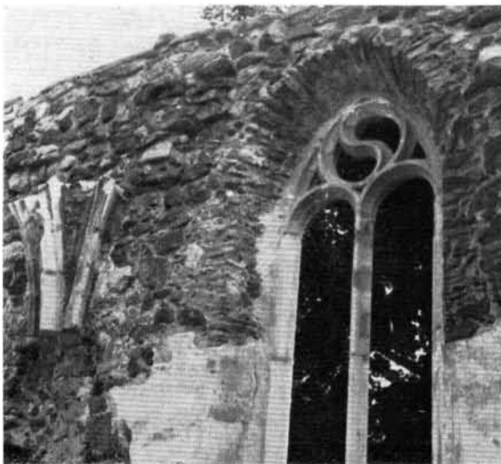
18. Helyreállított szentélyablak és boltozatindítás. 18. Apsisfenster und Gewölbesockel nach Herrichtung. 18. Fenêtre du choeur et naissance de voûte reconstruites. 18. Восстановленное окно святилища и пята свода.
