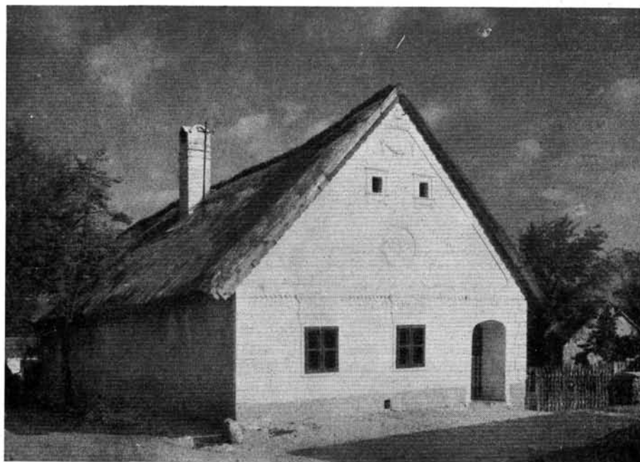
15. Út homlokzat a helyreállítás után. 15. Die Gassenfront nach der Restaurierung.
