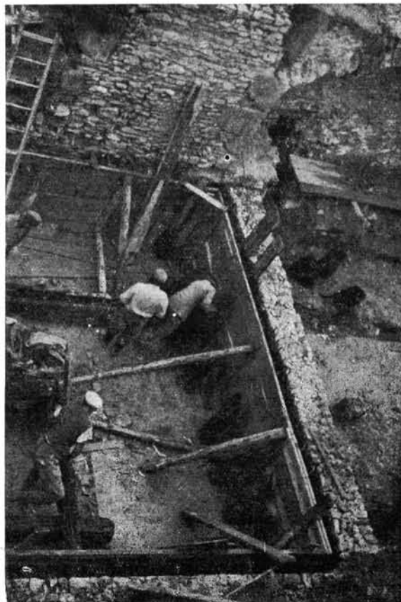
321. kép. A farkasverem betonmedencéjének zsaluezése Abb. 321. Schalung des Betonbassins der Wolfsgrube
