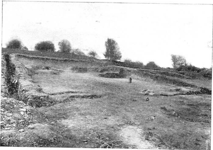
3. A lakótelep délkeletről nézve.
