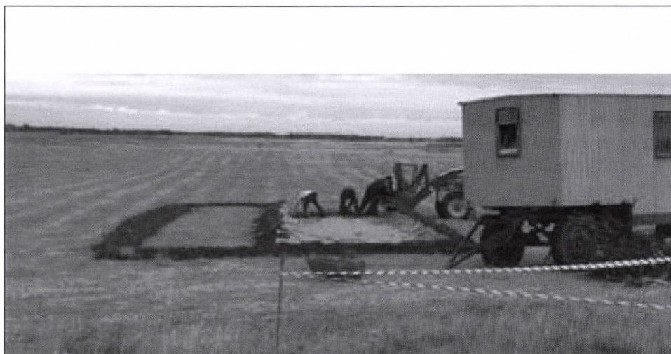
5. kép. Gyepőglák elhelyezése a földgátas fóliamedencében, 2011. július (Fotó: Greksza János, KMNPI)
