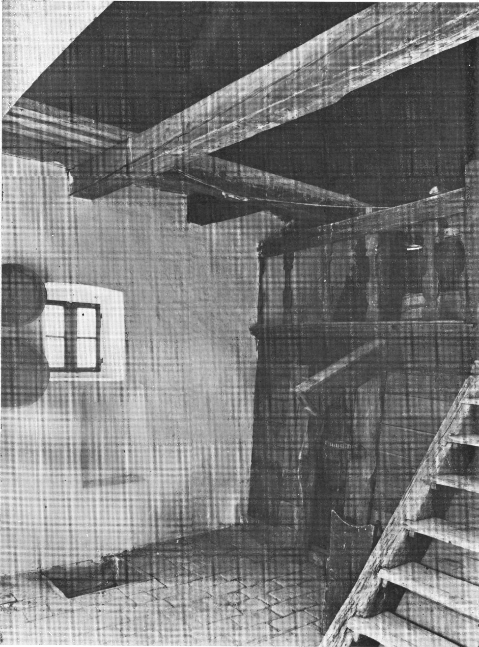
30. kép: Malomház belső, daráskő felőli részlete, helyreállítás után Figure 30: Interior of mill-house, detail from grits-stone, after restoration
