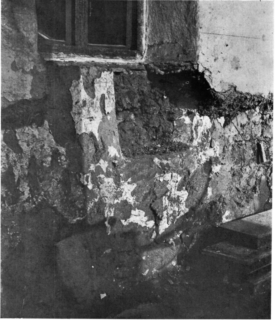
8—9. kép: A falkutatás során előkerült ablak helye, a padlásfeljáró mellett. (foto: Remeckzy Ferenc) Figures 8—9: Position of window found beside the attic entrance during the examination of the walls (photograph by Ferenc Remeckzy)
