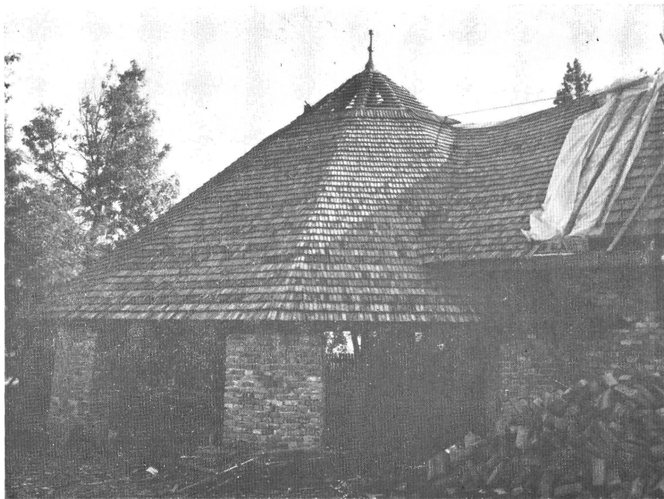
22. kép: A szárazmalom helyreállítás közben Figure 22: The horse-driven mill during restoration
