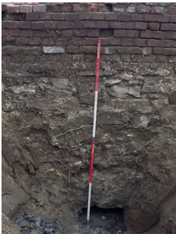
17. ábra. A főtorony alapozása.
