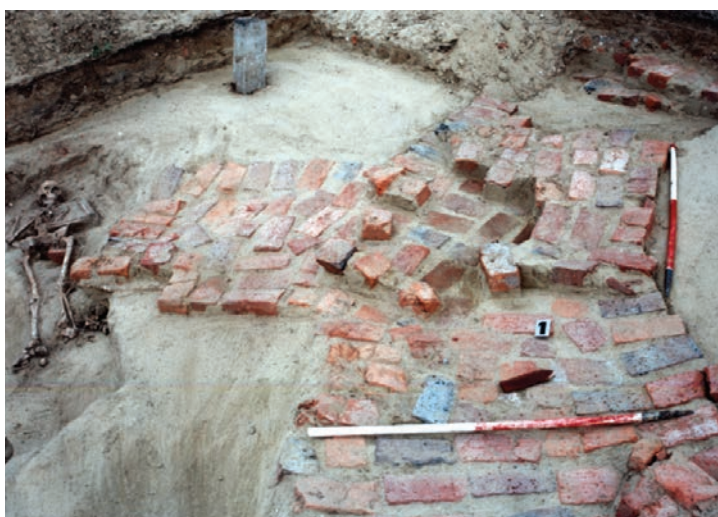
3. ábra. A bódvicai templom alapozásának téglái
