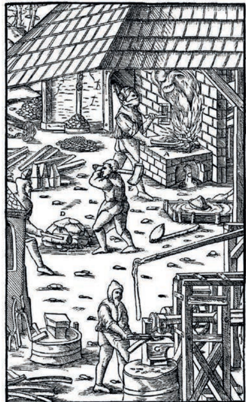
12. ábra. Bucakemence és vastörő a 16. században (AGRICOLA IX. könyv 220. ábra)
