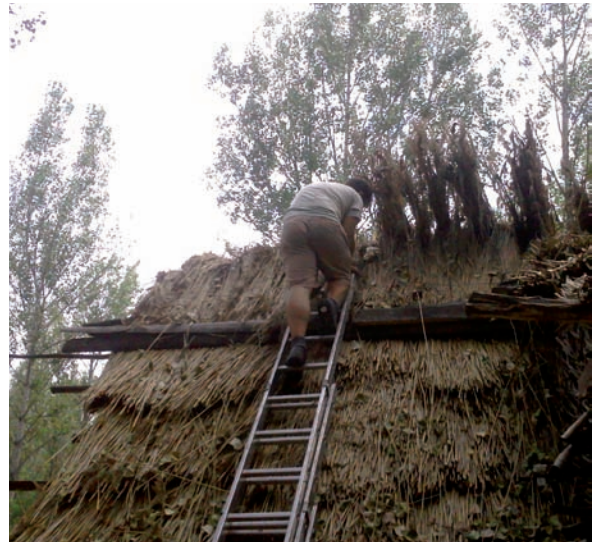
5. kép: A tető náddal való befedése
