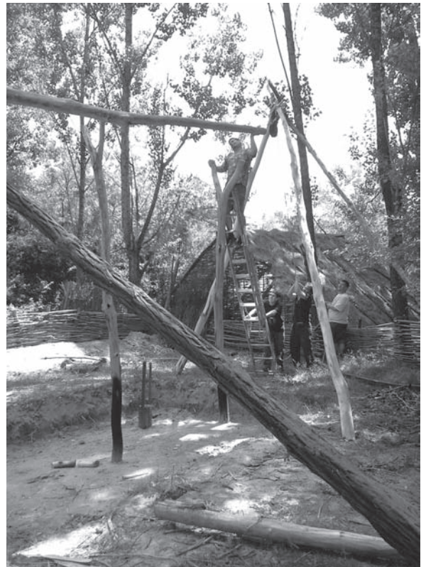
3. kép: A tetőszerkezet építése
