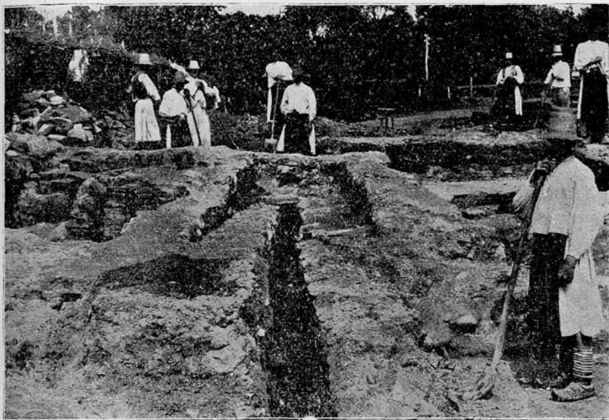
6. sz. kép. Az F és H helyiségeken átmenő csatorna.
