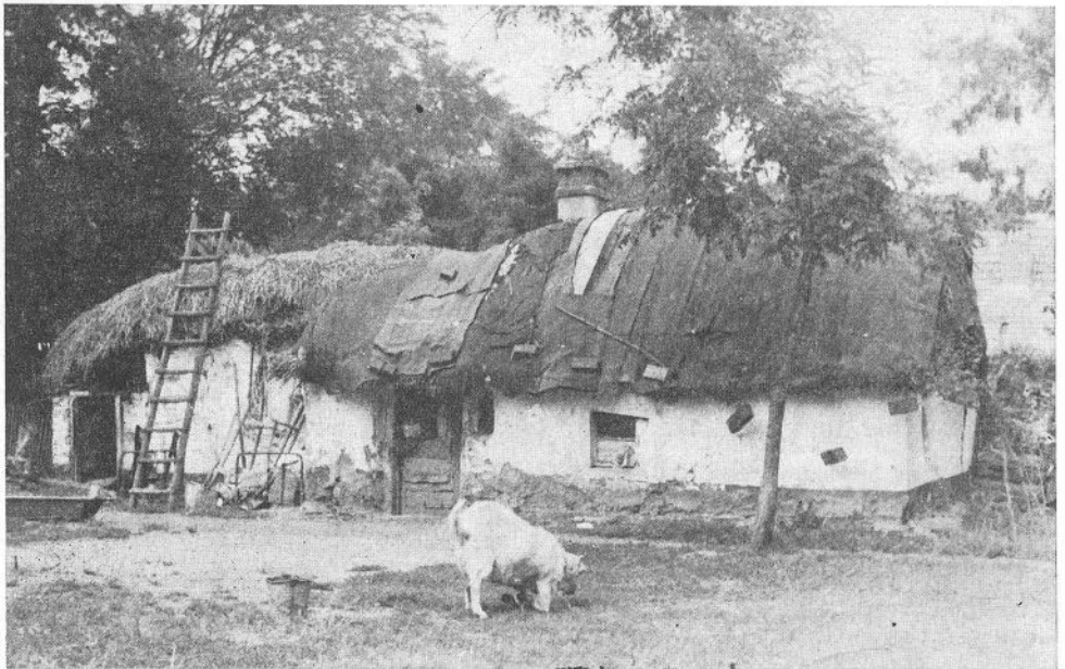
Abb. 6. Wohnhaus mit einem in die Erde eingelassenen Fussboden. Öcsöd, (Kom. Szolnok). Aufn. L. Dám
