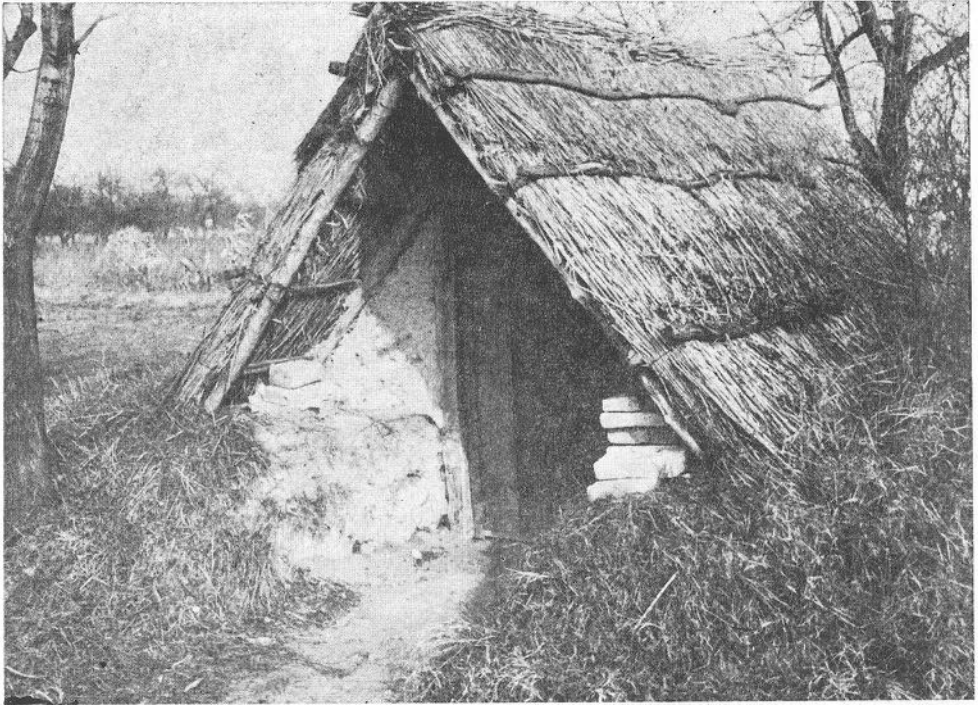
Abb. 3. Weingartenhütte mit einem in die Erde eingelassenen Fussboden. Albertirsa, (Kom. Pest). Aufn. L. Novák
