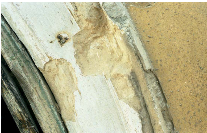
16. kép. A főépület bejáratának kőkeretei az 1850-es évek kemény, barna színű vakolatból készült javításaival, részlet. Fotó: Mentényi Klára, 1998
