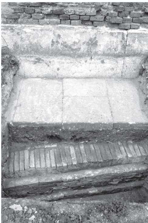
27. kép. Az 1850-es évekből származó csatornarendszer a vele együtt készült lábazati mészkő lapokkal és a főépületet körülvevő kőjárával. Fotó: Mentényi Klára, 1997
