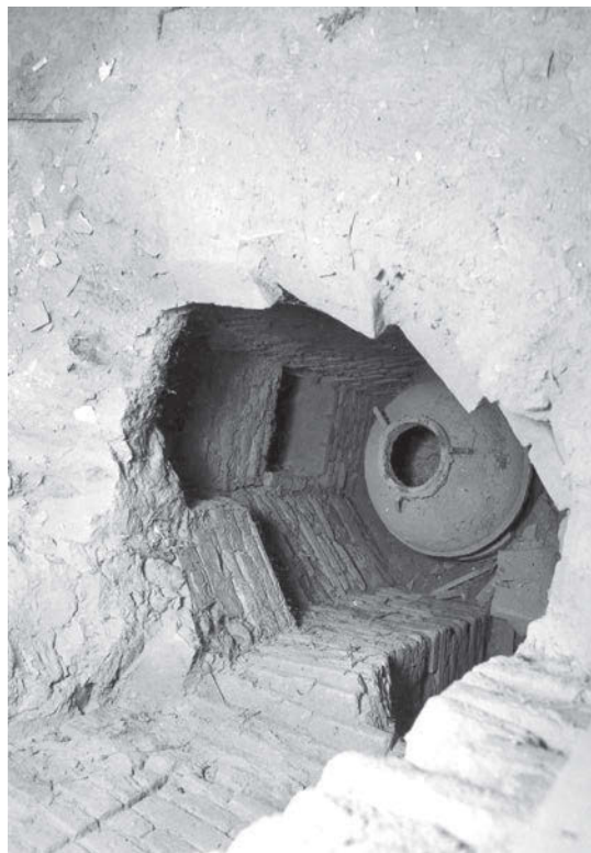
28. kép. A nyugati szárny északra eső pincéjében fennmaradt öntöttvas cisztérna, a téglafalban kialakított vízvezető nyílással. Fotó: Mentényi Klára, 1997
