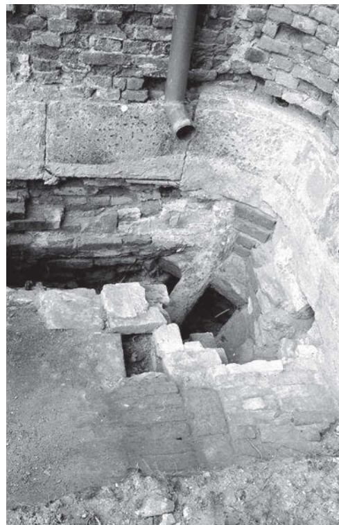
26. kép. A főépület délkeleti udvari belső sarkán feltárt 19. század közepi csatorna-rendszer egykorú öntöttvas cső részletével. Fotó: Mentényi Klára, 1997
