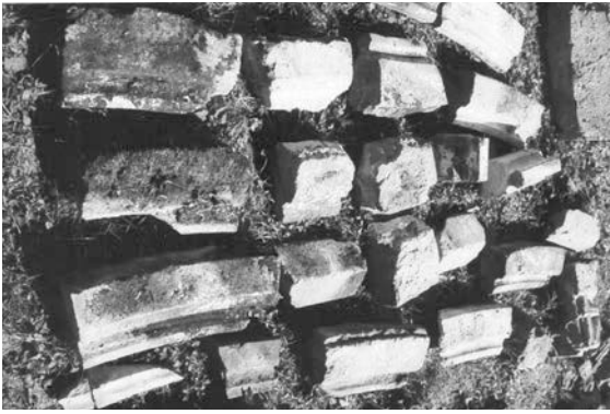
13. kép. Zalasántó, r. k. templom. A feltárt boltozati bordák. A szerző fotója
