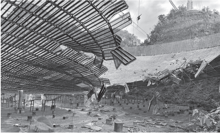
Az elszakadt kábel által okozott roncsolás a tányér szerkezetén (University of Central Florida)
