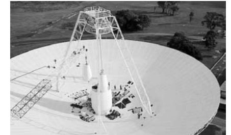
A 70 méteres DSS–43 a felújítási munkák közben (CSIRO)
