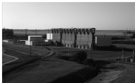
3. ábra • Kiégett fűtőelemek átmeneti tárolója
