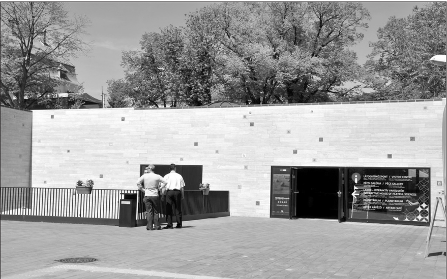
A planetárium bejárata
