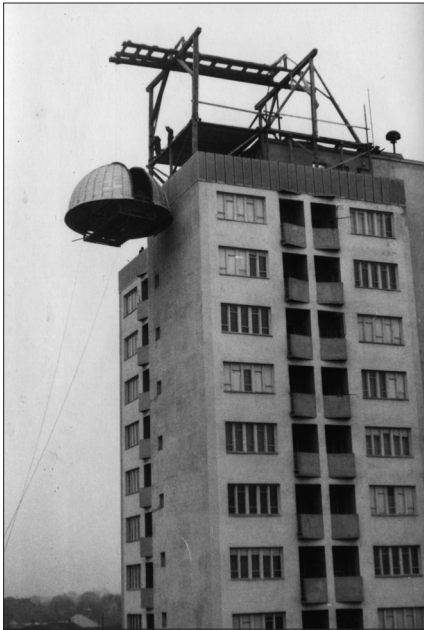
A toronyházi csillagvizsgáló kupolájának beemelése az 1960-as évek elején
