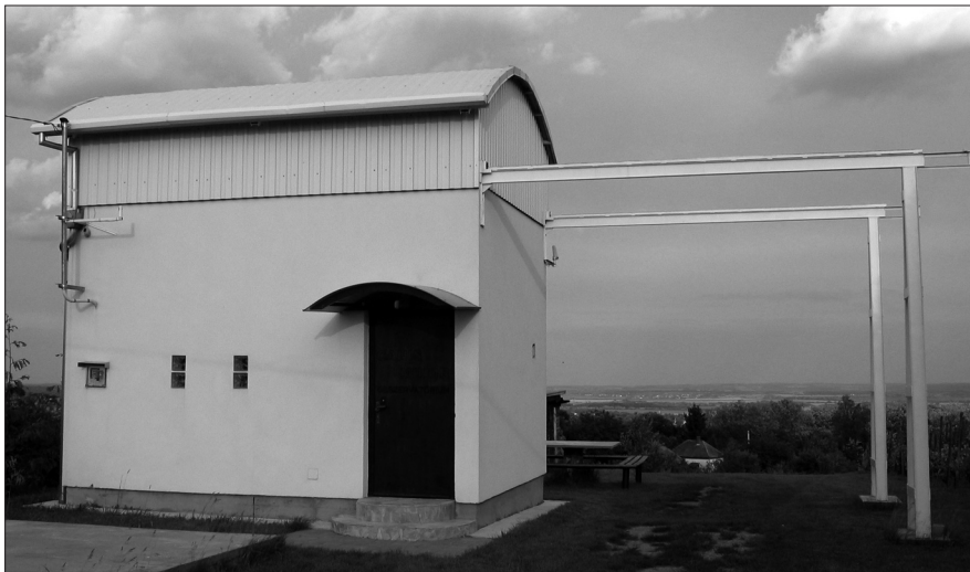
A becsehelyi Canis Minor Observatórium letolható tetős épülete
