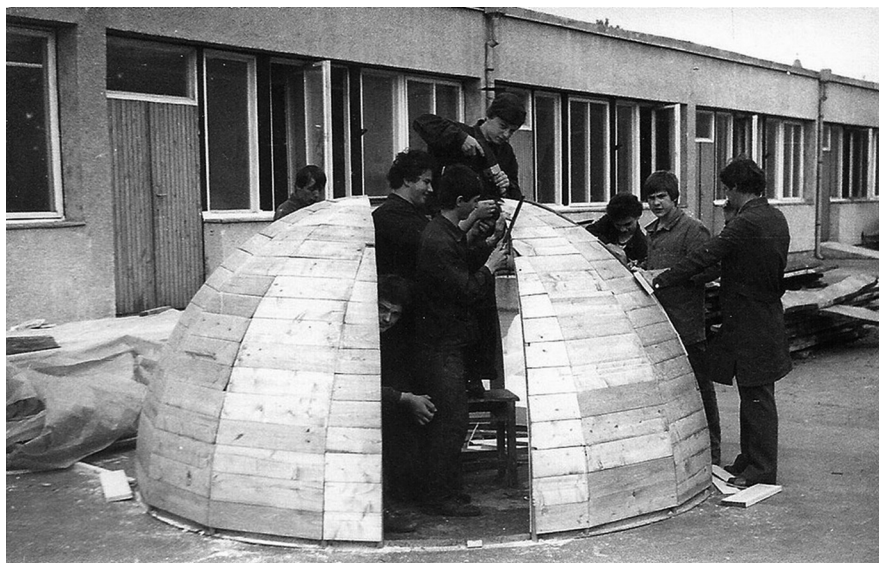
Készül az Aquila Csillagvizsgáló faserkezetes kupolája a pápai 304. sz. Szakmunkásképző Intézet udvarán
