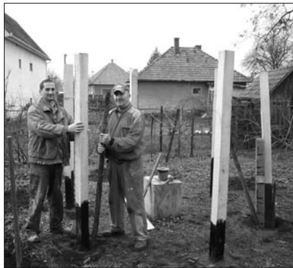
Földbe kerültek a vázszerkezet tartóoszlopai
