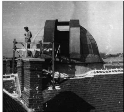
A kupola építése II.(1950)
