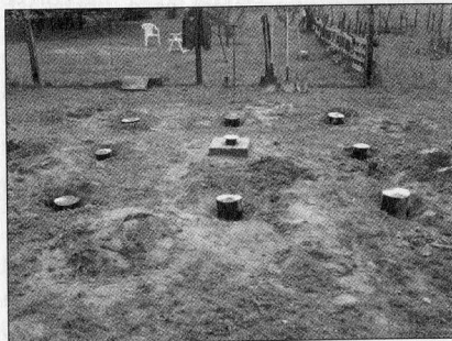
Kész az alapozás – még az észlelőhelyiség nélkül
