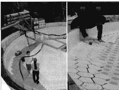
2. ábra. Az öntőforma készítése
