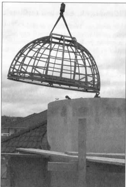
Az acélszerkezet darus beemelése
