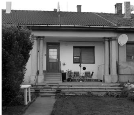
A nagytagyosi Konkoly-kúriát mára alaposan átépítették, de a bejárati lépcső megőrizte eredeti formáját
