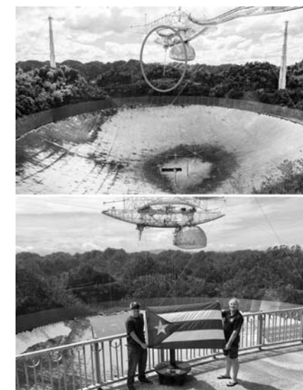
A rádióteleszkóp 2014-es, sértetlen állapota (fent), illetve az obszervatórium két munkatársa a hurrikán elvonulta után. Figyeljük meg a letört antenna helyét (a felső képen jelölve)
