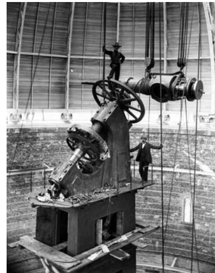
Készül a 40 hüvelykes óriásrefraktor tengelykeresztje
