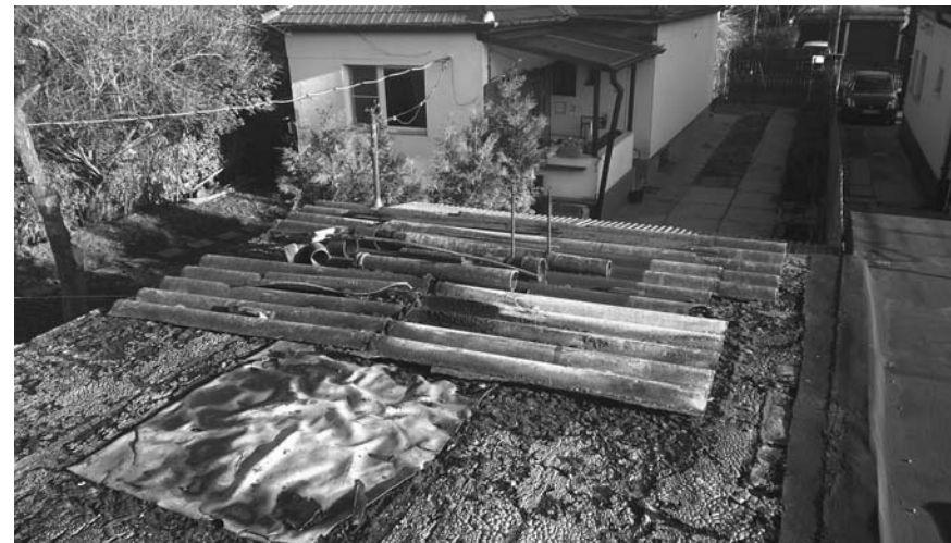
A garázstető állapota a munkálatok megkezdése előtt
