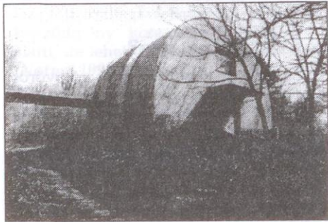
A passzázsműszer épülete a vákuumcsövekkel
