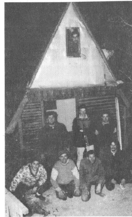
A dági faház — közvetlenül bontás előtt, eredeti felállítási helyén (fotó: Lantos Zsolt)
