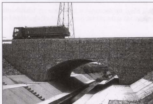
2. kép Félhéjas TUBOSIDER hídszerkezet GABION támfallal
