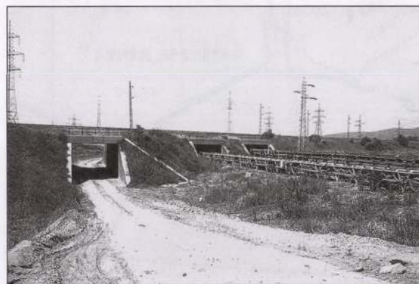
3. kép Vasbeton kerethidak
