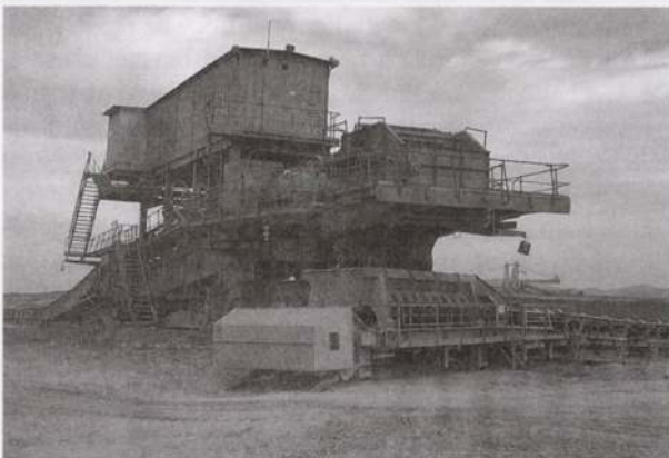
3. kép Új kivitelezésű szalagvég
