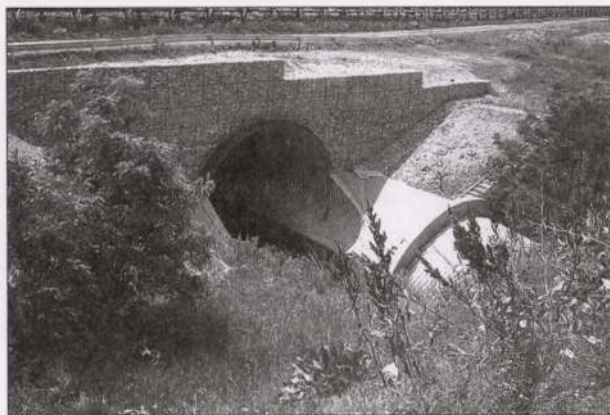
1. kép Kőrszelvényű TUBOSIDER hídszerkezet GABION támfallal
