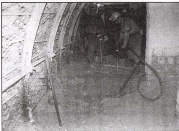
1. ábra: Olajjal szennyezett kőzet felszedése
