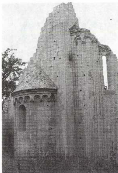
5. ábra. A vértesszentkereszti apátági templom részben helyreállított maradványa
