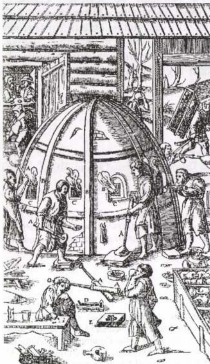
1. ábra. Kemence kész üvegáru előállítására Agricola könyvében
