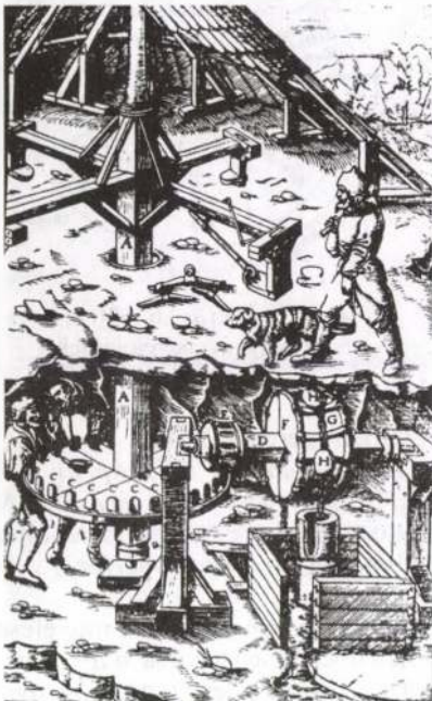
5. ábra. Lőjörgánnyal hajtott labdás vízemelőgép Selmecbányán . (Agricola: A bányászatról és kohászatról, Budapest, 1985)
