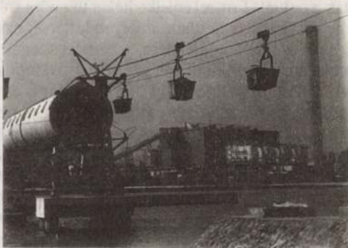
5. ábra. A csőhid egyik betonalapja és rácós alátámasztó acélszerkezete
