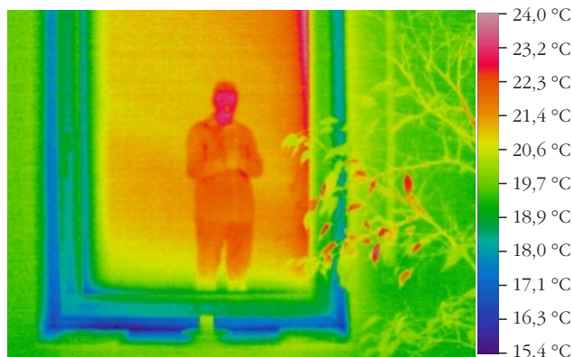
1. ábra. Épületrész hőtérképe. (Forrás: http://www.bau-sv.de/thermographie/thermo-5/thermo-5.html )
