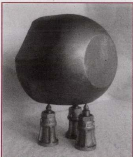
2. ábra. GJS-400-18 és GJS-500-7 jelű gömbgrafitos öntöttvas csomópontok, melyek az 1. ábra szerinti „biomok” tetőszerkezetét hordják
