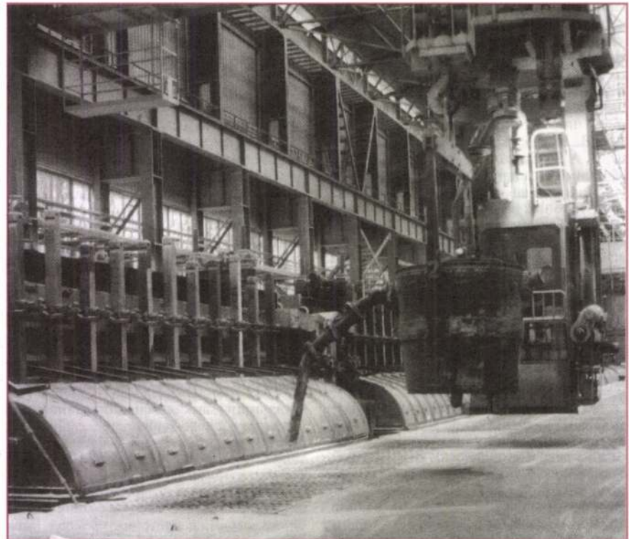
1. ábra. A korszerű, blokkánódos elektrolizáló kádak
