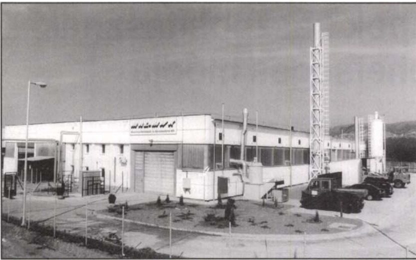
A rövidesen felavatásra kerülő MAL-MWK Kft. alumíniumkokilla-öntőde üzemcsarnoka
