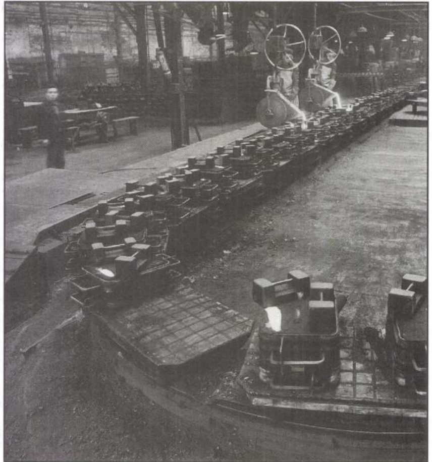
2. ábra. Kocsis konvejer a Csepeli Vas- és Acélöntődé 2. sz. vasöntődjében 1957-ben
