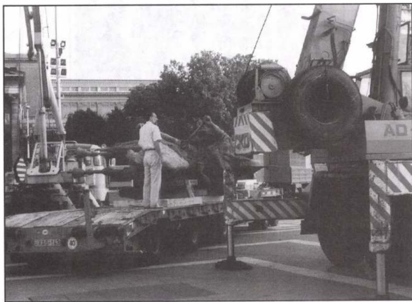
8. ábra. A felújított szobrok közül Árpád vezérére érkezett utoljára a Hősök terére, ahol két daru segítségével állították a plintuszára
