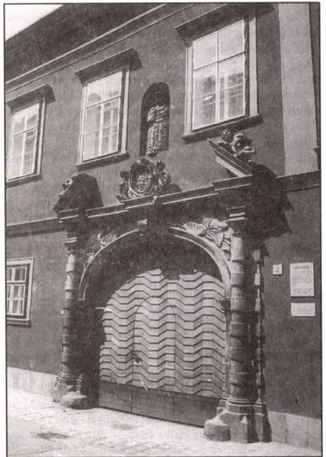
Fassade des Zentralmuseums für Bergbau A Központi Bányászati Múzeum homlokzata
