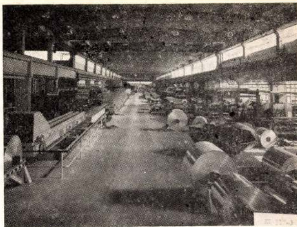
3. ábra. A Tvornica Lakih Metala Sibenik Könnyűfémű szalaghengermű csarnoka
